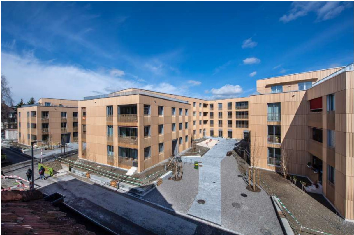
Die Umgebungsarbeiten schreiten voran
