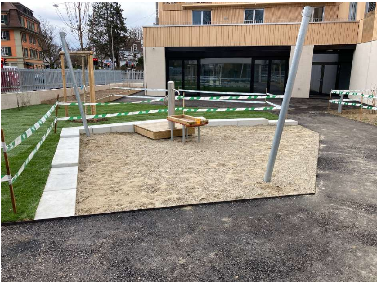
Aussenraum der Basisstufe
