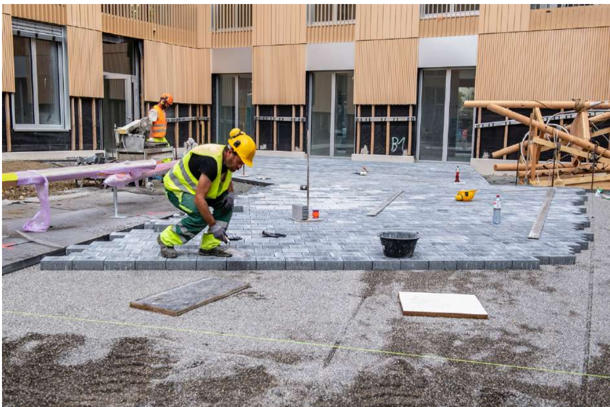
Pflasterung der Innenhöfe
