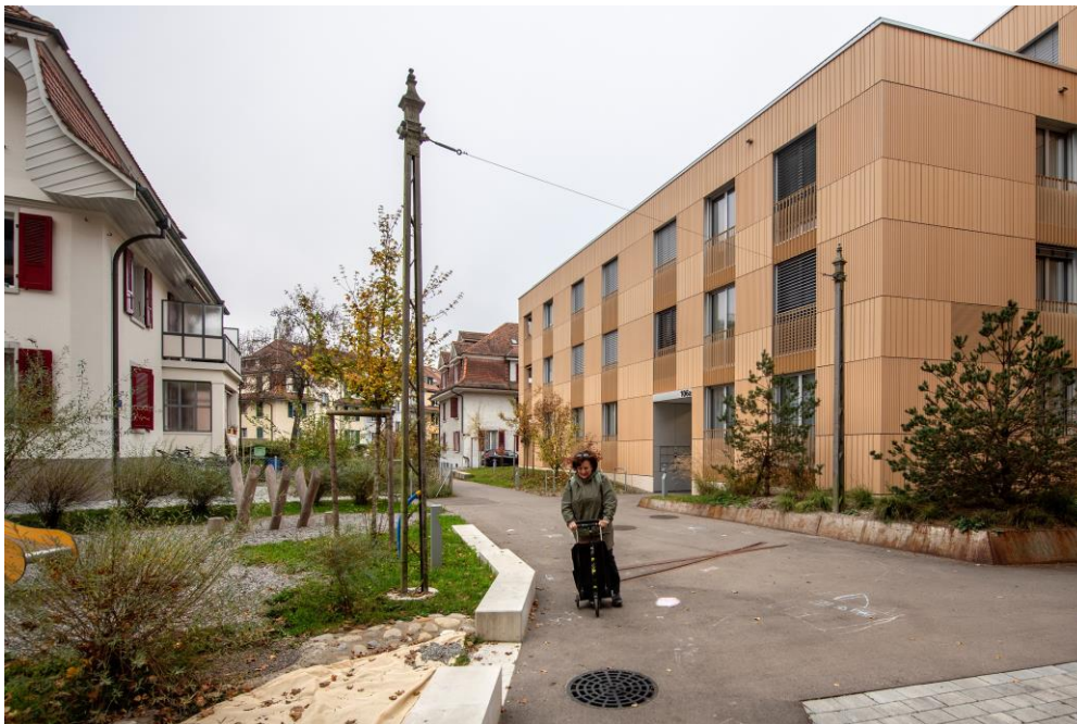
Fahrleitungsmast im Hof beim Restaurant MUNA (Foto L. Lehmann)
