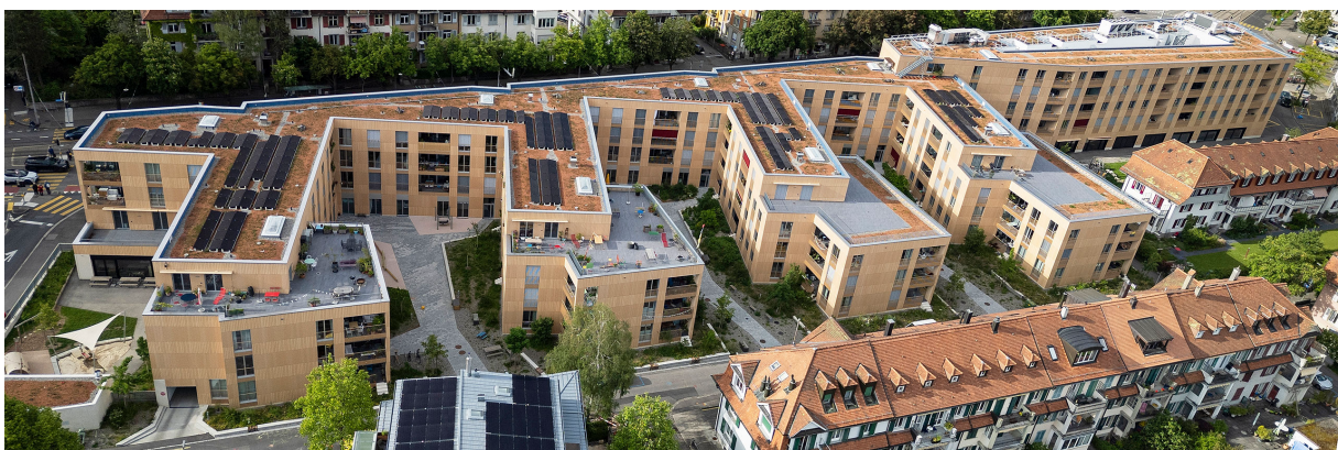
Bild: Luftaufnahme der Überbauung Burgernziel (L. Lehmann)
