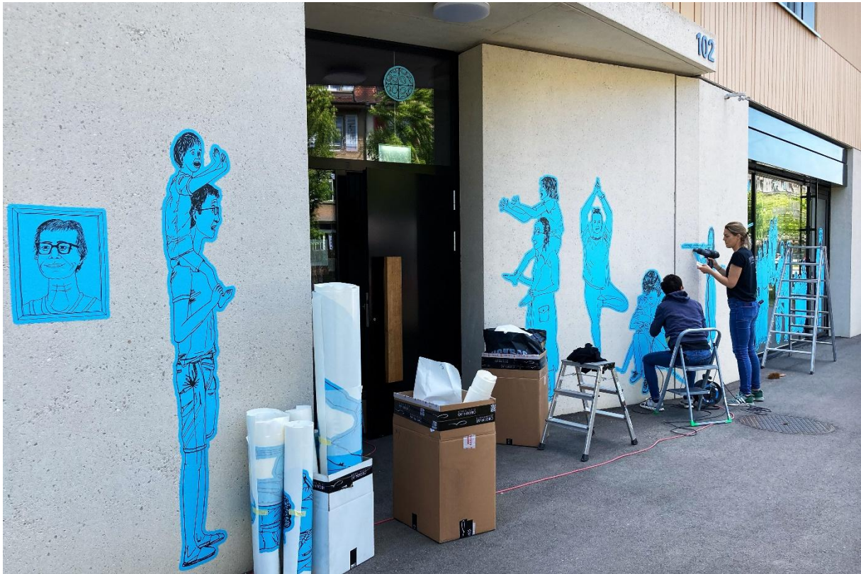
Bekleben der Fassade Thunstrasse 100-102 (Foto L. Lehmann)
